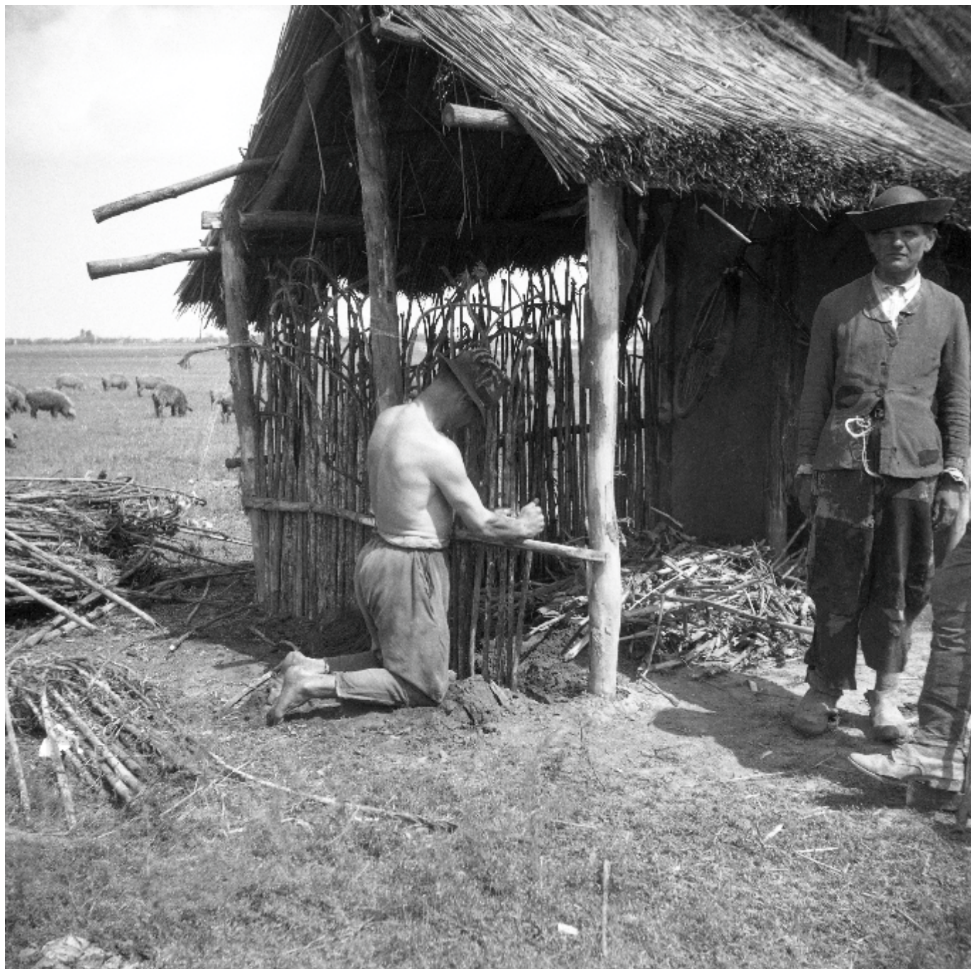
KONDÁSKUNYHÓ FALÁNAK KÉSZÍTÉSE / CREATING THE WALL OF PIGMANSHUT PRÓD, 1951
